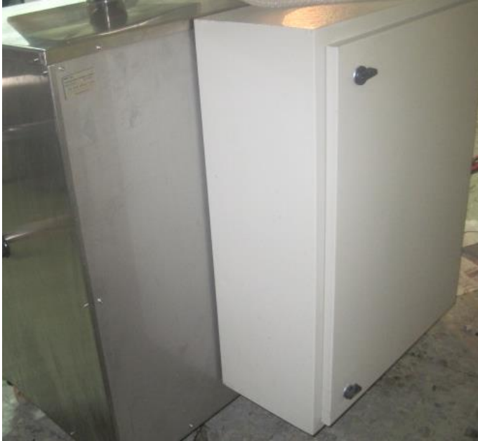
شکل ۲- تابلو برق مربوط به سیستم کنترل
